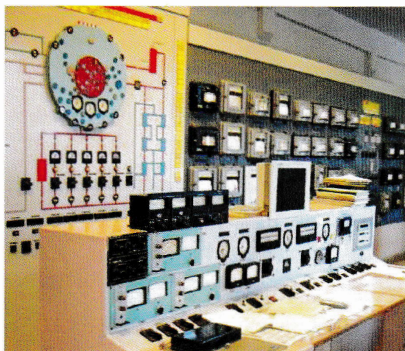
Пульт управления реактора ВВР-ц
