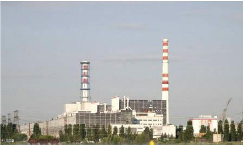
Курская атомная электростанция (построена в 1985 году): мощность - 4000 МВт, 4 энергоблока типа РБМК-1000 (мощный каналный реактор с графитовым замедлителем).
