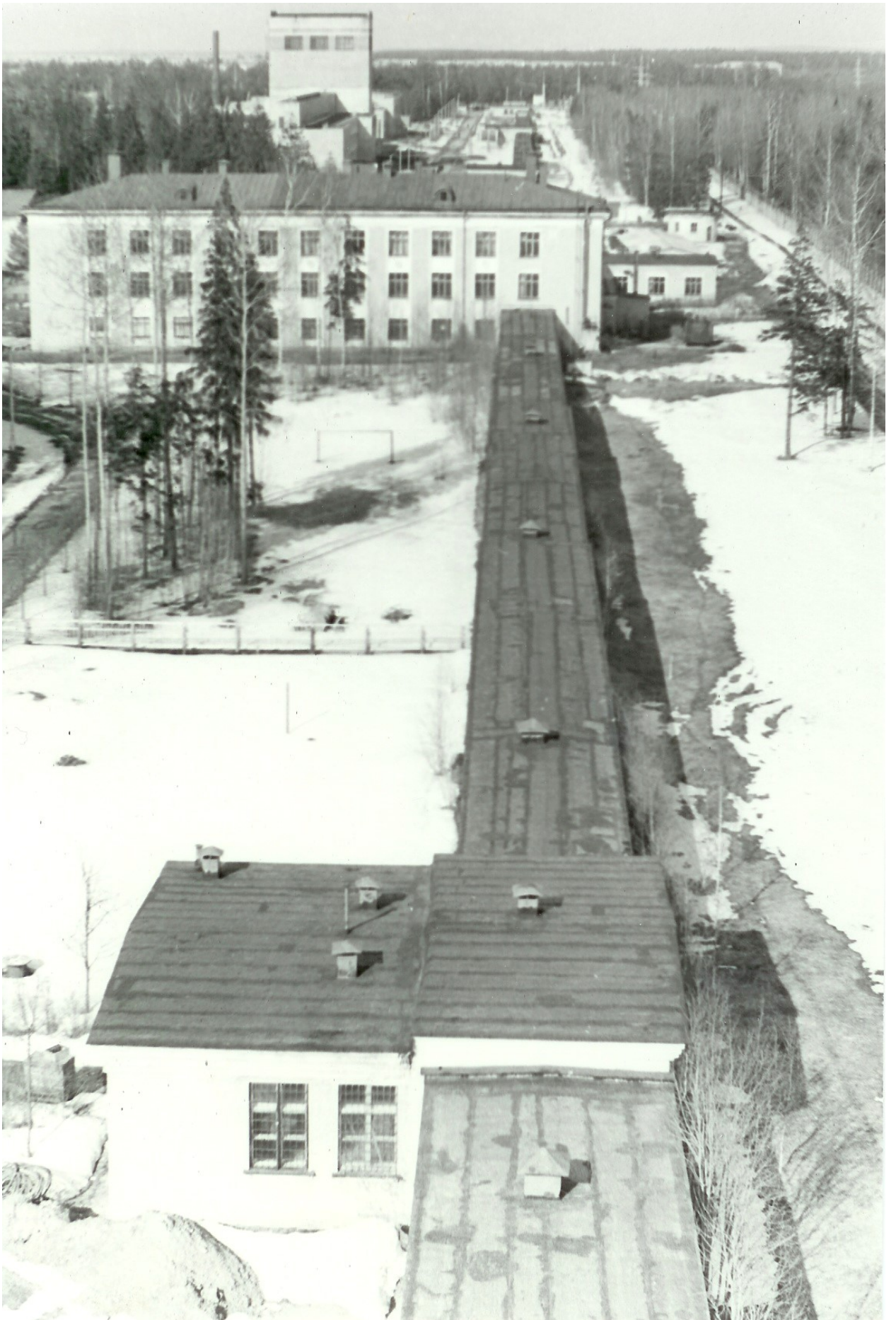
Вид на здание управления ИБР-30 и 1000-метровую пролетную базу.
