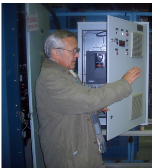
Рис.10. Электропривод фирмы Toshiba 22 кВт для фонового прерывателя (слева) и два электропривода 2,2 кВт для λ-прерывателей (справа).
