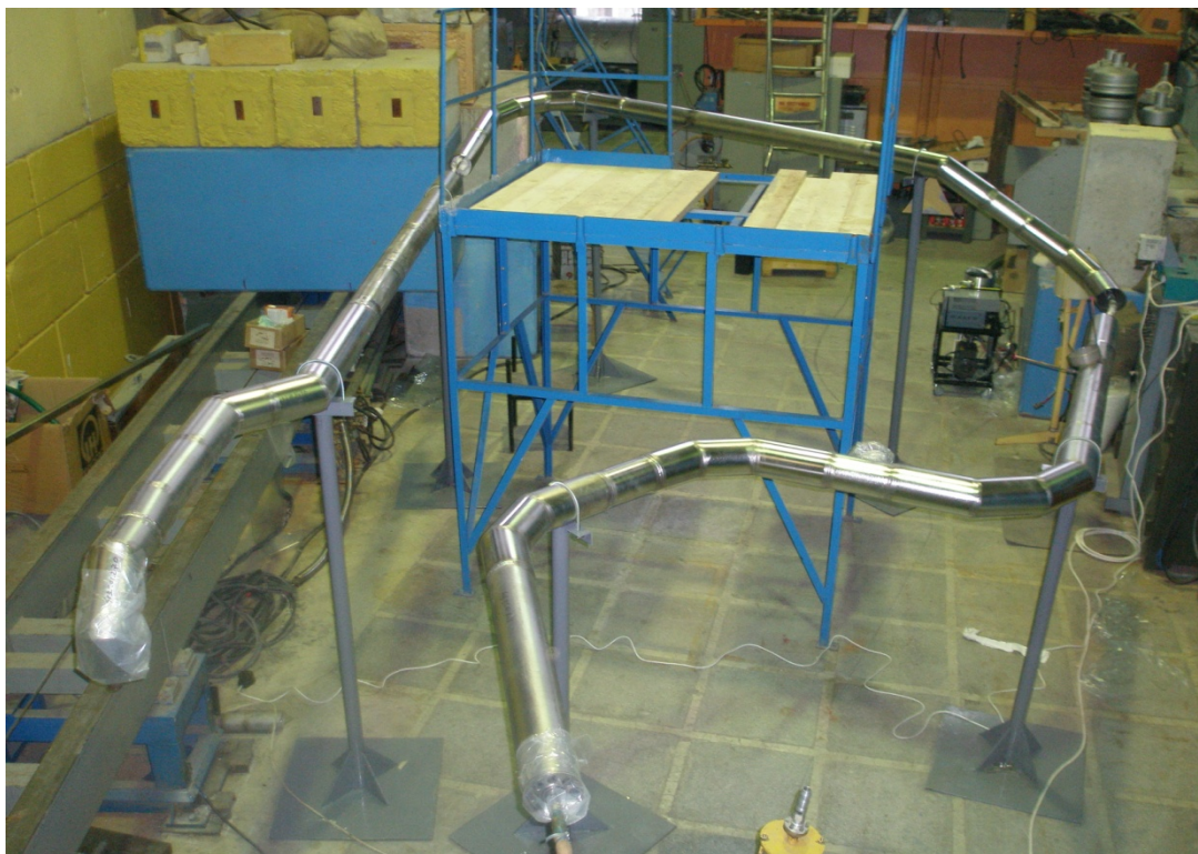
Рис. 2 Монтаж криогенной транспортной трубы)
